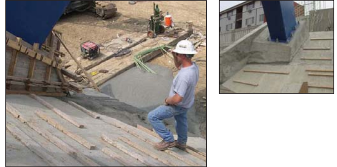
(Abutment Pedestal in Des Moines, Iowa)
